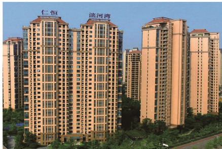
2016年成都仁恒滨河湾一期荣获鲁班奖，总建筑面积168027平方米
